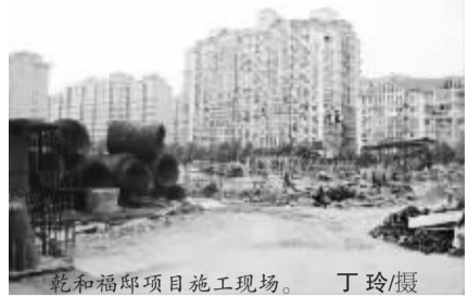
乾和福邸项目施工现场。丁玲/摄
